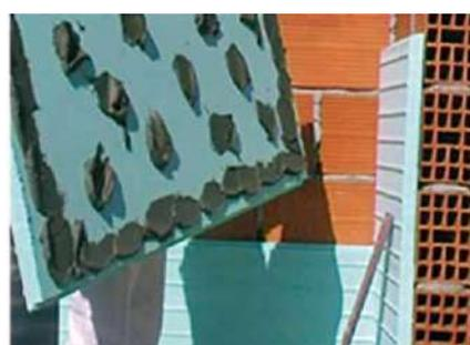
3. APLICAR CORRECTAMENTE LAS PLACAS DE XPS RESPETANDO LAS RANURAS.
