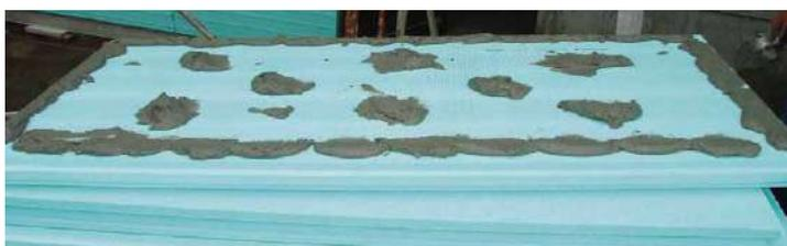
2. APLIQUE EL ADHESIVO A LA PARTE POSTERIOR DE LAS PLACAS DE XPS (PEGADO PUNTUAL Y PERIFÉRICO O TOTAL).
