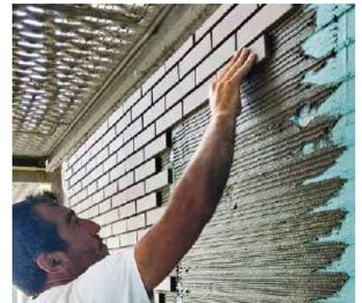
**6.** APLIQUE LAS PLAQUETAS KLINKER CARAVISTA, EMPEZANDO POR LAS ESQUINAS Y COMPROBANDO LA ALINEACIÓN DE LAS JUNTAS VERTICALES.
