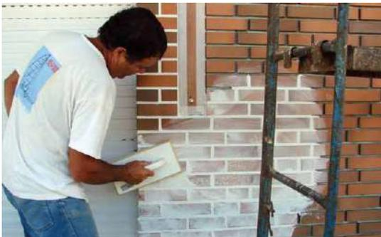
**7.** PREPARE Y APLIQUE EL MORTERO CANDIWALL® REJUNTEO RELLENANDO COMPLETAMENTE LAS JUNTAS.
